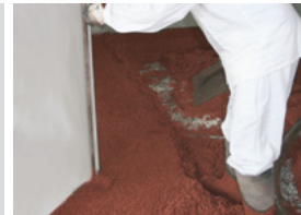
Izraditi kutne visine, (fašne) nasipati, zbiti i poravnati visinu.
