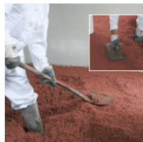
Priključne rubove prema zidu naknadno obraditi, a nanoseni materijal na površinu zbiti.
