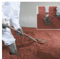
Priključne rubove prema zidu naknadno obraditi, a naneseeni materijal na površinu zbiti.
