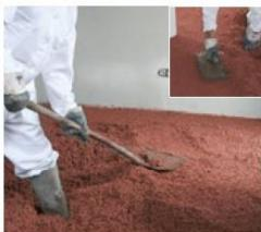
Priklučne rubove prema zidu naknadno obraditi, a i naneseni površinu **zbiti**.
