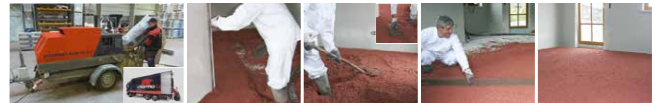
3 Säcke mit Wasser (Menge je nach Produkt) in Estrichpumpe zu einer homogenen Dämmung mischen (mind. 2 Min. Mischzeit).
