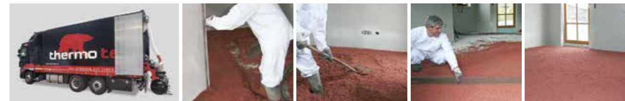
Lieferung, anmischen und pumpen erfolgt durch das thermotec® Mixmobil
