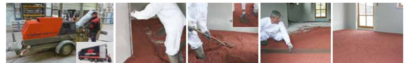
1 Sack mit Wasser (Menge je nach Produkt) in Estrichpumpe zu einer homogenen Dämmung mischen (mind. 2 Min. Mischzeit).
