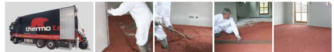
Lieferung, anmischen und pumpen erfolgt durch das thermotec® Mixmobil
